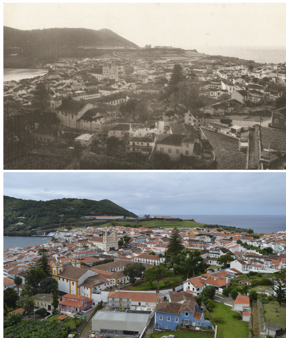
Figura 47 – Vista da Memória sobre a cidade. Em cima, imediatamente após o sismo. Fotografia gentilmente cedida por Rúben Quadros. Autor desconhecido. Em baixo, em agosto de 2019. Fotografada por Miguel Jarroca
