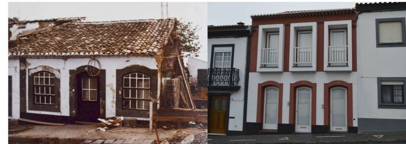
Figura 42 – Edifício na Rua Madre de Deus 19, 19A. À esquerda, fotografia da fachada no início de 1980 (ficha 1018 da Inventariação do Património Arquitectónico, DGPU). À direita, fotografia da fachada em 2019 (Miguel Jarroca).
