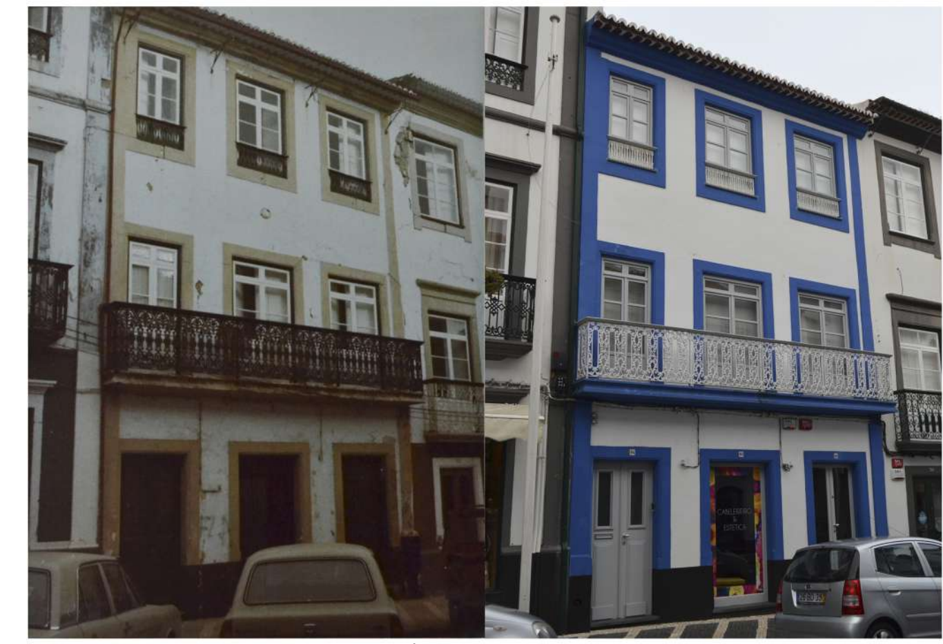
Figura 22 – Edifício na Rua de São João 80, 82, 84. À esquerda, fotografia da fachada no início de 1980 (ficha 508 da Inventariação do Património Arquitectónico, DGPU). À direita, fotografia da fachada em 2019 (Miguel Jarroca).
