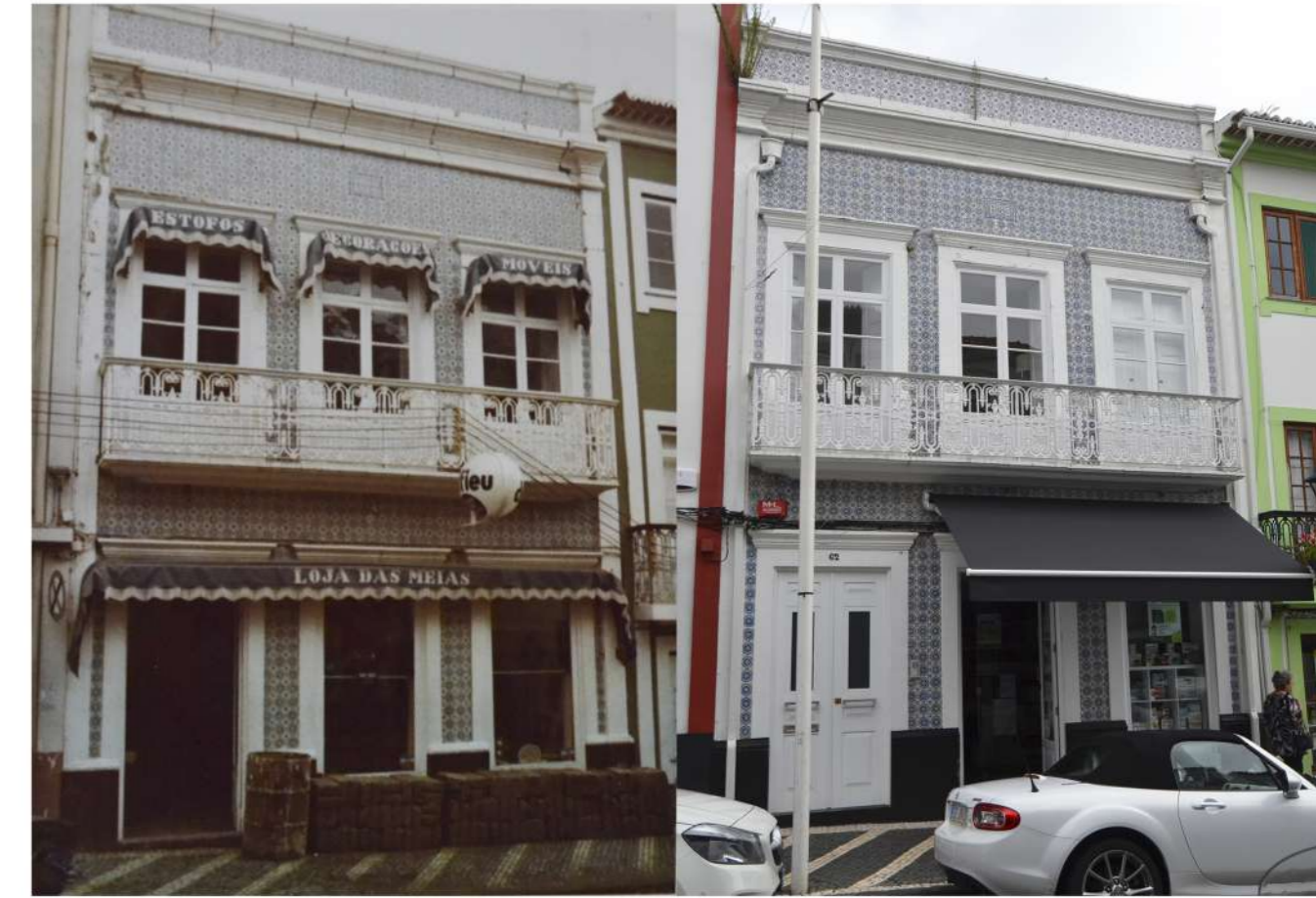
Figura 24 – Edifício na Rua de São João 58, 60, 62. À esquerda, fotografia da fachada no início de 1980 (ficha 504 da Inventariação do Património Arquitectónico, DGPU). À direita, fotografia da fachada em 2019 (Miguel Jarroca).
