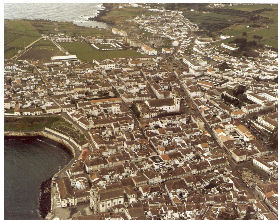
Figura 48 – Vista aérea da cidade destruída após o sismo onde se pode observar a retícula e, ao fundo, o "acampamento do Bailão", ainda composto por tendas. Fotografia gentilmente cedida por Rúben Quadros. Autor desconhecido
