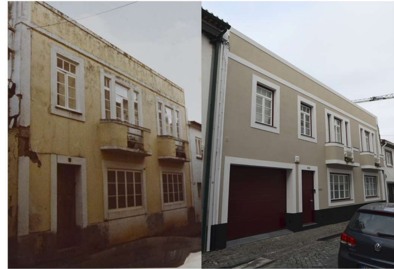
Figura 34 – Edifício na Rua de Jesus 48A. À esquerda, fotografia da fachada no início de 1980 (ficha 306 da Inventariação do Património Arquitectónico, DGPU). À direita, fotografia da fachada em 2019 (Miguel Jarroca).
